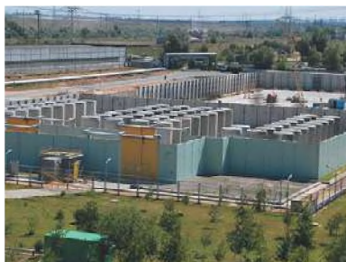
Рис. 3. Зона зберігання радіоактивних відходів під відкритим небом на Запорізькій АЕС
