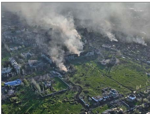
Рис. 5. Зруйнований Бахмут. AP Photo/Libkos
