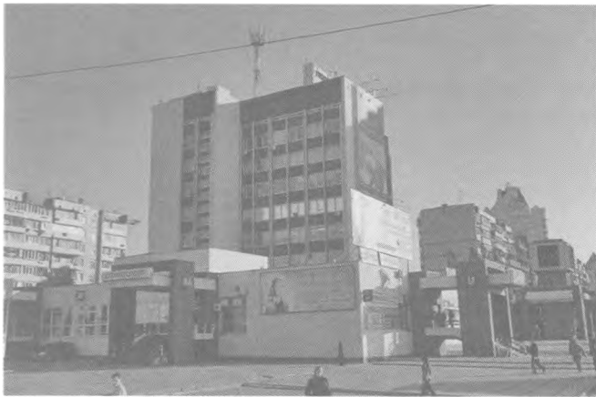
Будинок побуту «Оболонь», архітектор Б. Гудков
