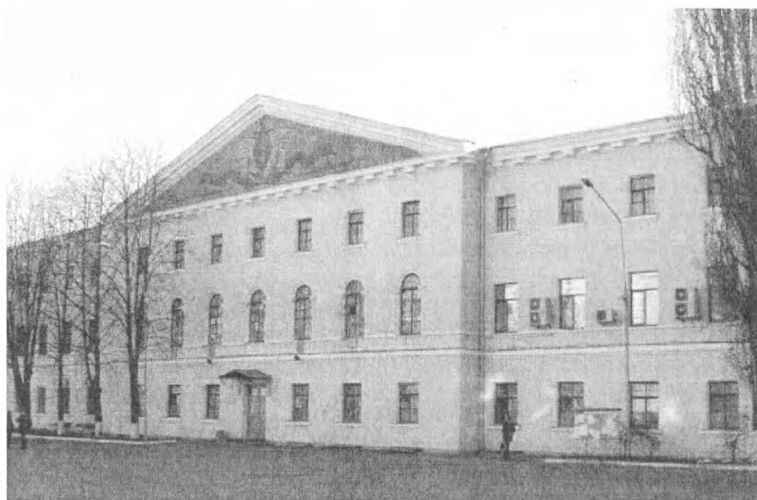
Новий академічний корпус - Перший корпус НаУКМА. Західний дворовий фасад
