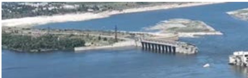
Зруйнована дамба Каховської ГЕС. Фото: ОК «Південь» https://surl.li/jlrctn
