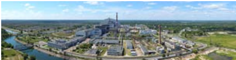
Чорнобильська атомна електростанція. Фото: ДСП ЧАЕС https://surl.lu/ntfils
