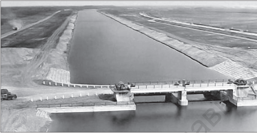
Фрагмент Північно-Кримського каналу.
