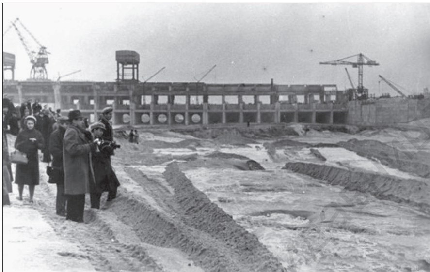
Будівництво Київської ГЕС.
